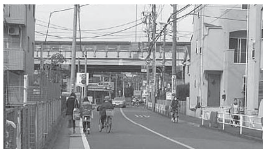
写真③ D区間に入るとガードレールがなくなり、狭い路側帯のみとなるため、車道上に歩行者、自転車、クルマが混在する
